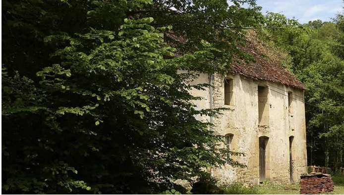
La Porterie, l'un des bâtiments annexes de l'abbaye ©Agir pour Cherlieu
